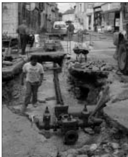
Pose d'une croix de répartition au Coin des cinq rues
