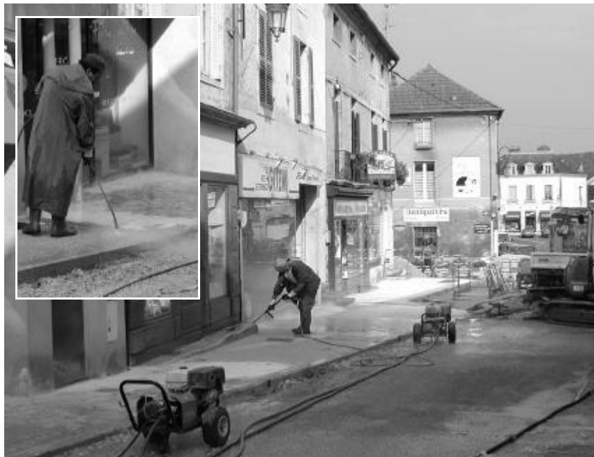
Les trottoirs : élimination de la couche supérieure désactivée pour un meilleur aspect et une sécurité plus grande.
