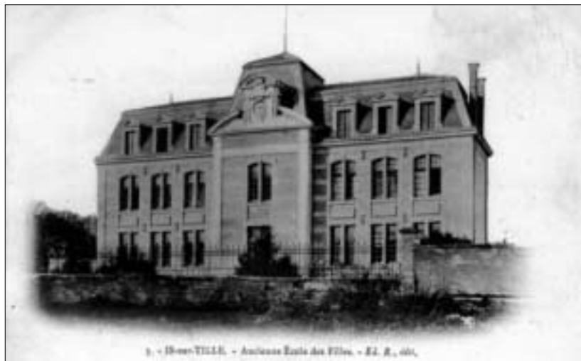
De 1887 à 1899 : l'école de filles, avant la construction des deux ailes
