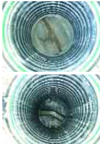
Nouveaux regards séparés : eaux de pluie et eaux usées
