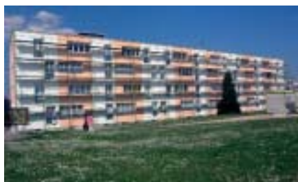
Rénovation des immeubles du Parc du Petit Bois
