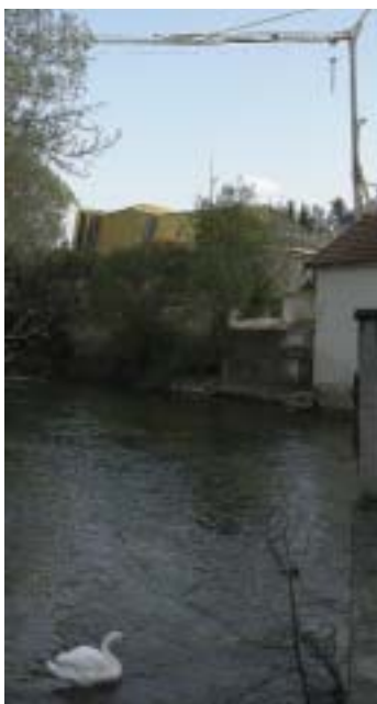
Construction du pôle médical
