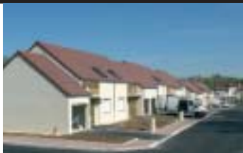
Rue Félix Laidet, constructions du Foyer dijonnais
