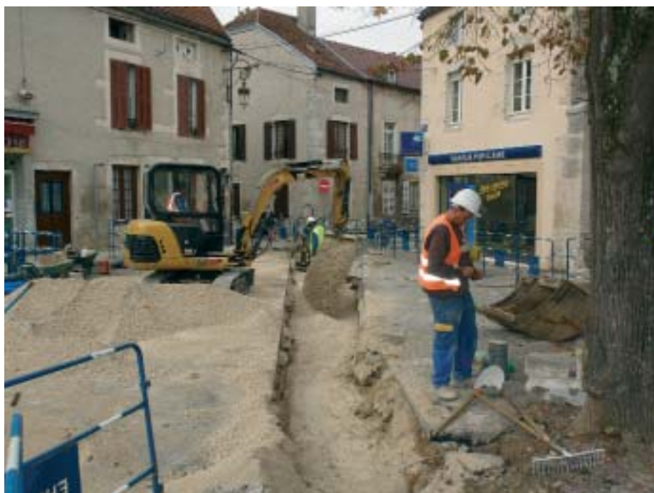
Travaux sur les réseaux souterrains rue Dominique-Ancemot et place Général-Leclerc
