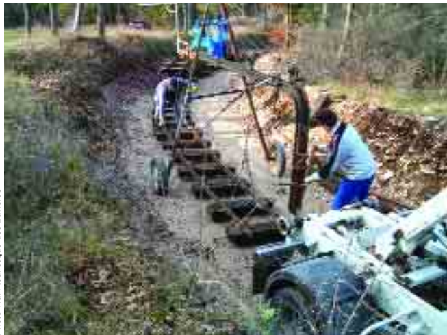
Pose des rails pour l'extension du circuit
